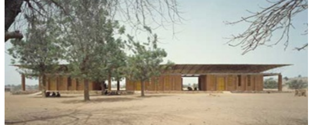
Ampliación Escuela de Dano en Burkina Faso. Mención especial en "Most thought-provoking +X" Projects (4th Cycle) en los premios de la World Architecture Community. Situado en la periferia de Dano, capital de la provincia de Ioba, el proyecto consiste en una adición con planta en forma de
