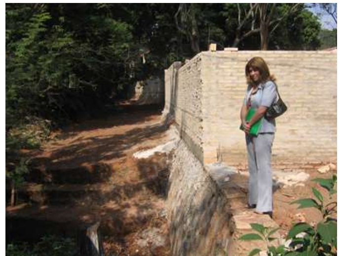
Gladys Caballero –directiva de G71- pareciera cuidar con celo su murallón construido en plena cárcava.
