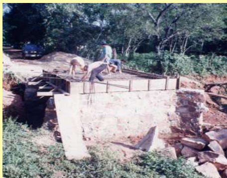
17) El puente de piedra y hormigón, en 1992, cuando era construido por la familia Arza. Puede observarse la amplitud de la cárcava que tuvo que rellenarse.
