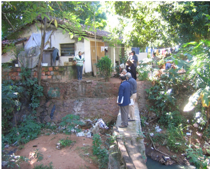
Los inspectores de Contraloría dialogando con vecinos del lugar, en la zona de mayor amplitud de la cárcava, a pocos metros de “Econatura II”
